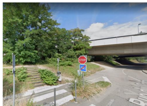
Figure 22: Zone N de la rue du Canal, en bordure du canal de Jonage (Google Street View, 2022)
